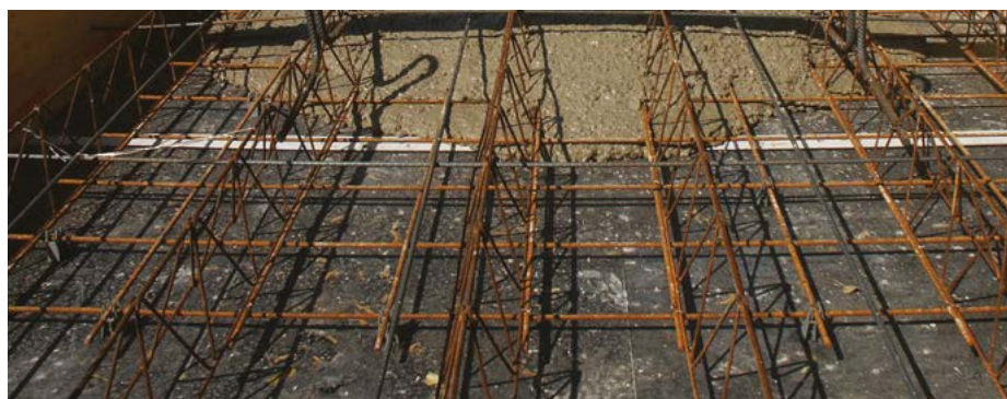
⑤ CONCRETE POUR
