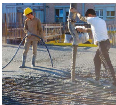
⑦ 2 nd STAGE OF THE CONCRETE POUR
