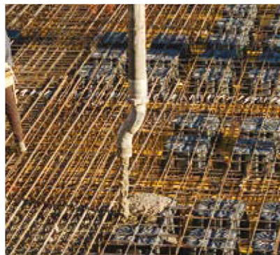
⑤ 1 st STAGE OF THE CONCRETE POUR
