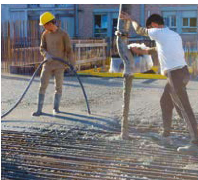
⑦ 2 nd STAGE OF THE CONCRETE POUR
